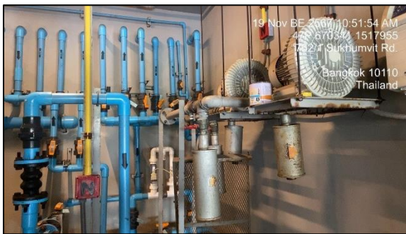
รูปที่ 11 ระบบสูบน้ำ
